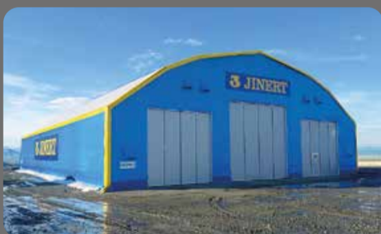
Varmisolerad mekhal för fordon, storlek 25x39x6 meter.
