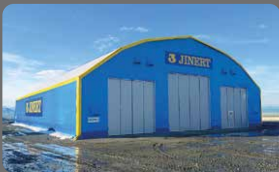
Varmisolerad mekhal för fordon, storlek 25x39x6 meter.
