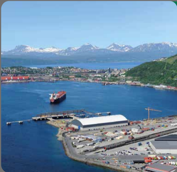
En av våra största hallar, onlastningscentral Narviks hamn. (BxLxH) 70x140x10 meter.
