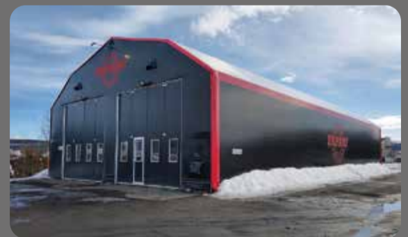
Varmisolerat garage, storlek 15x32x5 meter.
