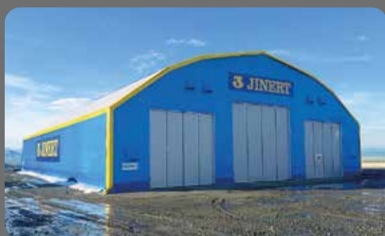
Varmisolerad mekhal för fordon, storlek 25x39x6 meter.
