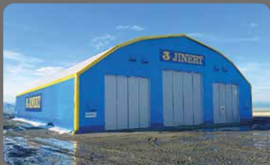
Varmisolerad mekhal för fordon, storlek 25x39x6 meter.
